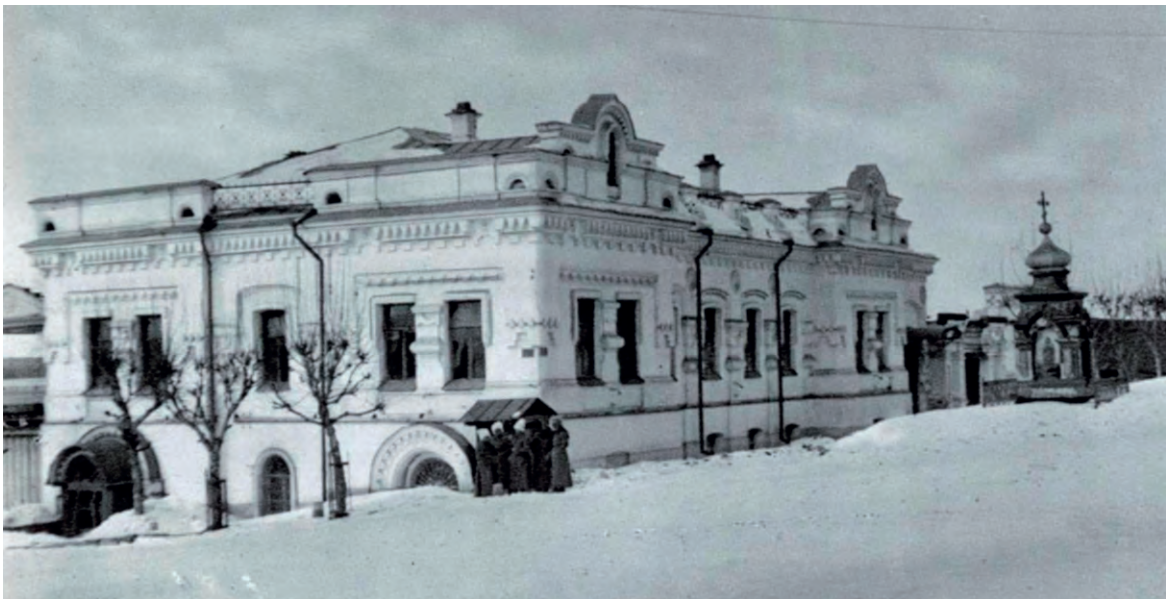
Дом инженера Ипатьева. Екатеринбург. Фото 1918 г.
